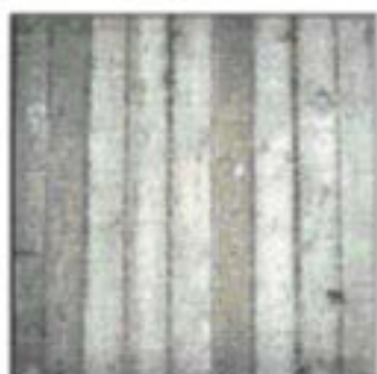
Figura 48.9 Variazioni di colore sulla superficie in evidenza poche ore dopo la rimozione delle casseforme
